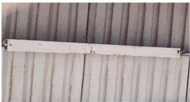
Foto 7: Sustrucción de lamparas LED + Sustrucción de plafoneras
