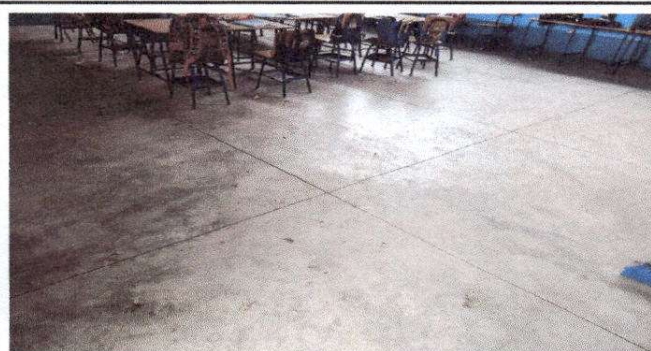
Foto 3: Sustrucción de piso de cemento líquido (por piso cerámico)
