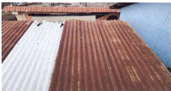
Foto 1: Sustrucción de lámina, por lámina troquelada aluzinc calibre 26 + Sustrucción de capote de lámina para lámina troquelada + Sustrucción de elementos de fijación
